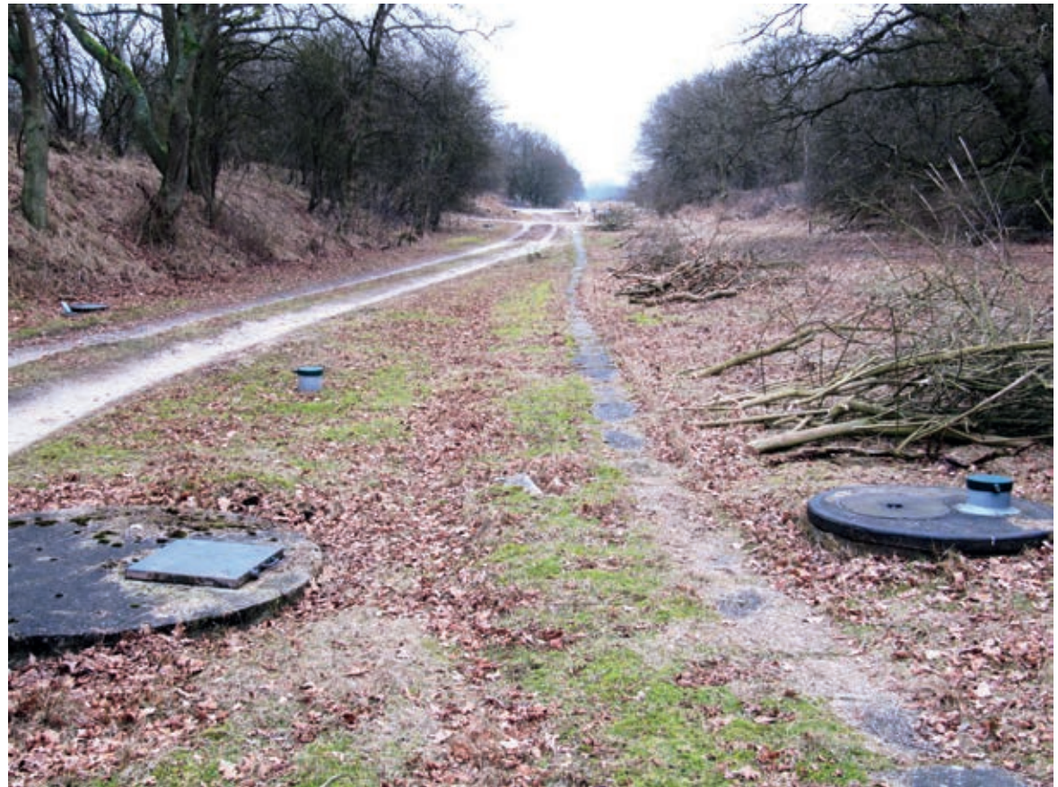
Sprangen of spranken vormen nu langgerechte laagten die het verder natuurlijke duinreliëf doorsnijden. Op de foto 'Sprank A' dicht bij Meijndel met puttenreeksen. In buizen direct onder de bodem van de sprang loopt het water nog steeds op natuurlijke wijze af richting pompstation.
